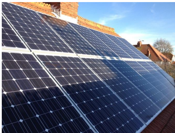
Figura 8: Foto ilustrativa de uma instalação com efeito de sombreamento Fonte: Site http://www.cosol.com.br/radiacao/ : Acesso em 25/05/2016
